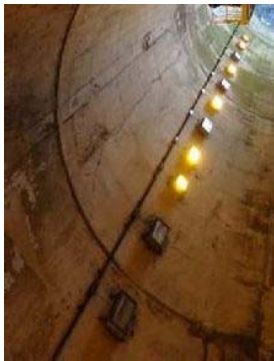
写真 3.4 覆工の天端付近に発生した縦断方向のひび割れの例 1)
