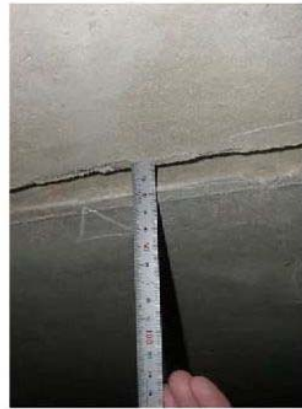
図 3.10 目地部、打継ぎ目前の段差の例
