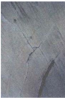
写真 3.6 縦筋のひび割れで覆工コンクリートがブロック化している例 1)
