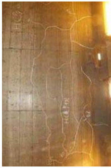
写真 3.6 縦筋のひび割れで覆工コンクリートがブロック化している例 1)
