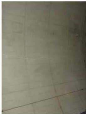
写真 3.4 覆工の天端付近に発生した縦断方向のひび割れの例 1)
