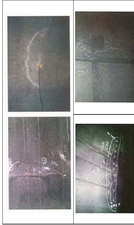
写真 3.1 横断目地の天端付近に発生した半月状のひび割れの例 1)
