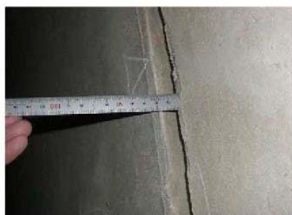
図 3.10 目地部、打継ぎ目部の段差の例
