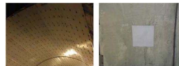
写真 3.11 鋼板接着；左・繊維シートの接着；右の例 ①
