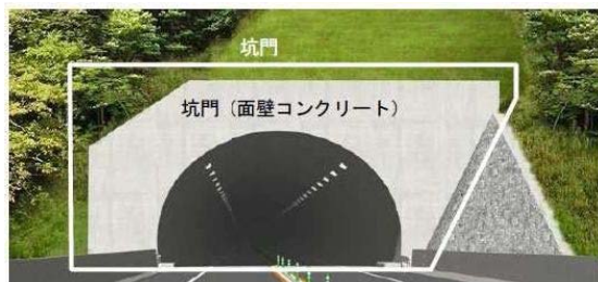
図 1.2 点検対象箇所（トンネル坑口部） 1)
