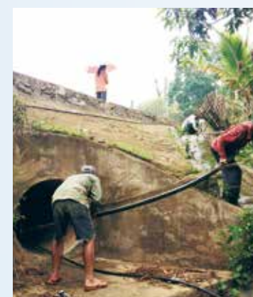
ラオスの活動地で、水源から病院に水を 引くパイプを設置。
