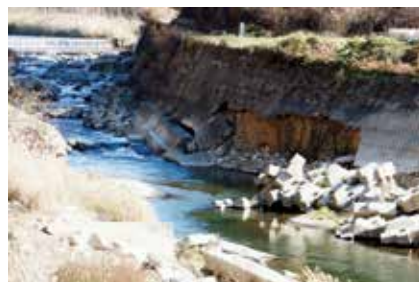
居倉 小川橋付近
