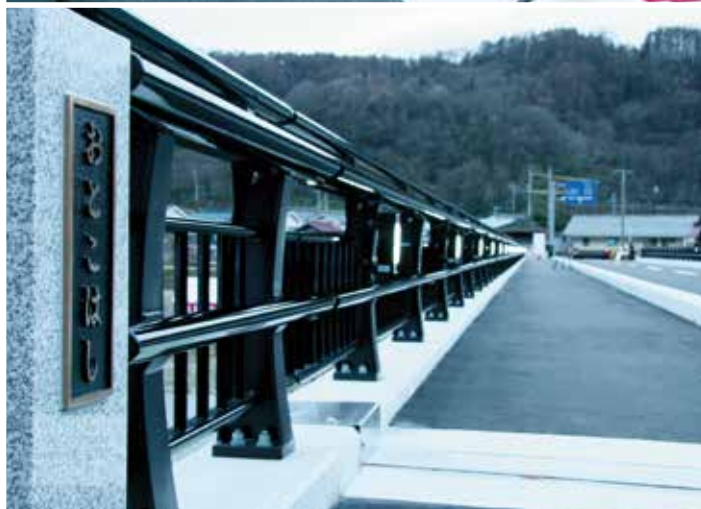
〈橋の概要〉 梓山海ノ口線 川上村 男橋 ・橋長88.6m・支間長29m×3 【上部】3径間連続非合成鋼鈹桁橋 【下部】逆T式橋台2基、壁式橋脚2基 【基礎】場所打杭2基
