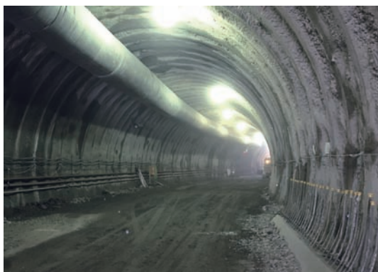
トンネル内部の様子
